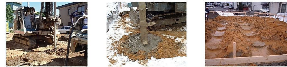
1 所定の深さまでスラリーと共に攪拌 2 固化材スラリーを注入しながら攪拌混合 3 基礎通りに杭打設します。 4 完成
